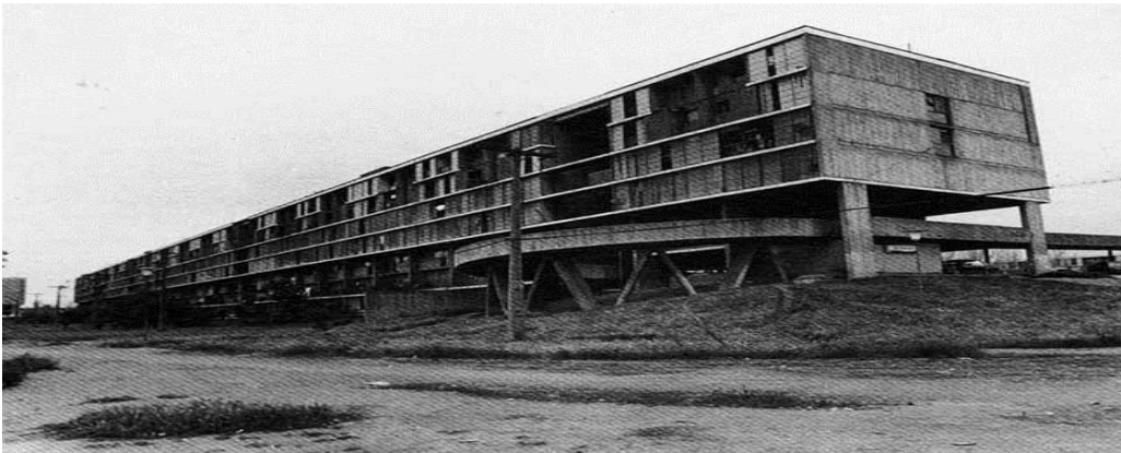
Unidad Vecinal Portales. Caja de Previsión de
